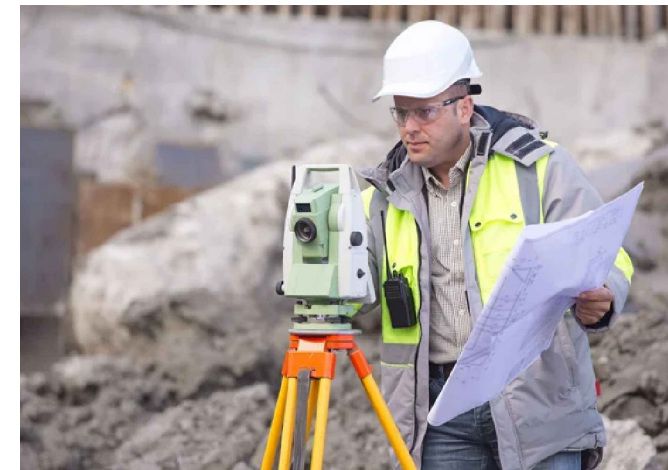
2 – Контроль точності монтажу
