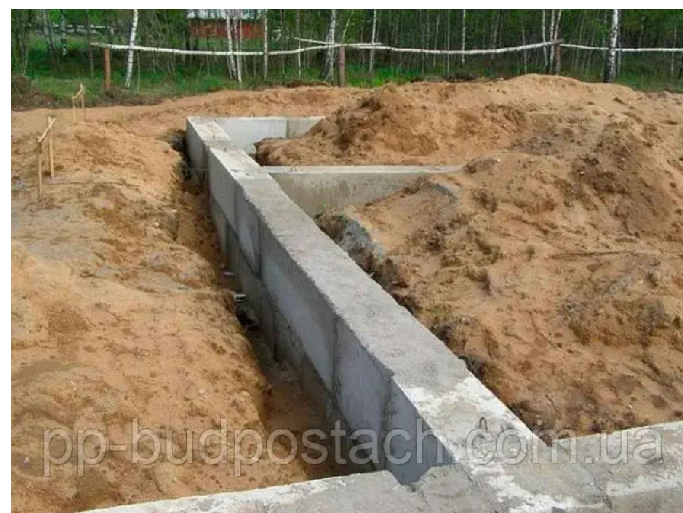
7 – Зворотня засипка фундаментів
