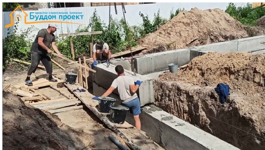
4 – Монтаж фундаментних блоків
