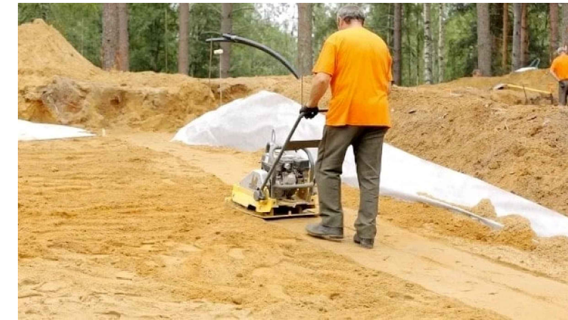
3 – Укладання та ущільнення піщаної подушки під фундамент
