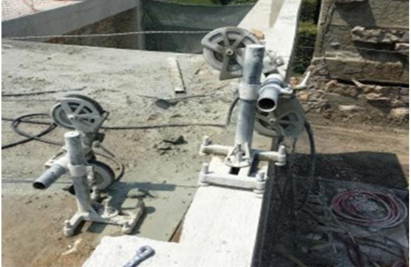
Рисунок 4.1 - Канатна ріжуча машина.
