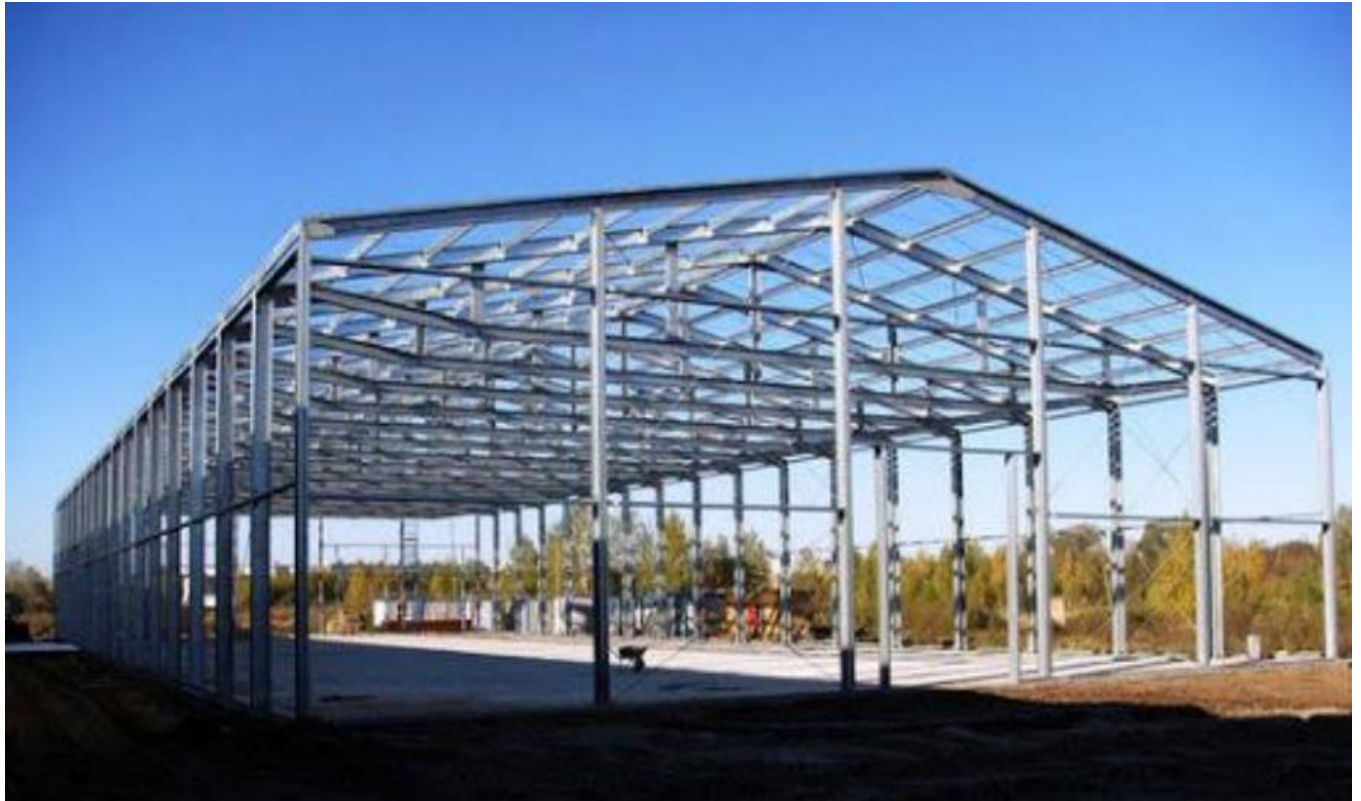
Рис 1.1.2 - будівельна метало конструкція.
