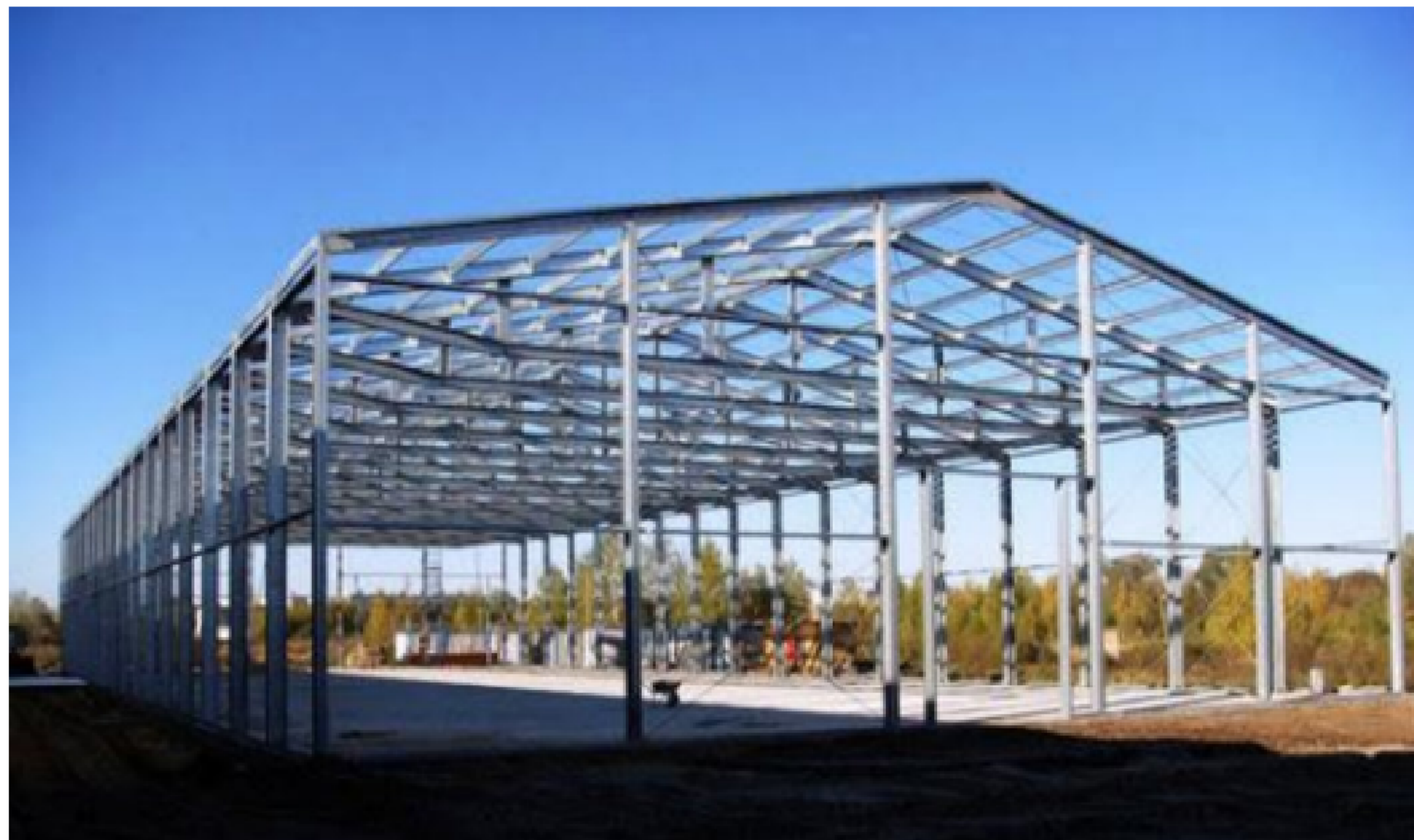
Каркас будинку з металпрокату
