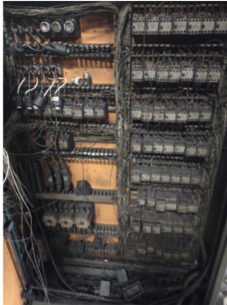
Рисунок 1.2 – Шафа керування застарілого зразка на базі релейної логіки [7]
