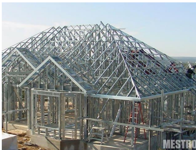
Рисунок 1.3 Будинок з металоконструкції
