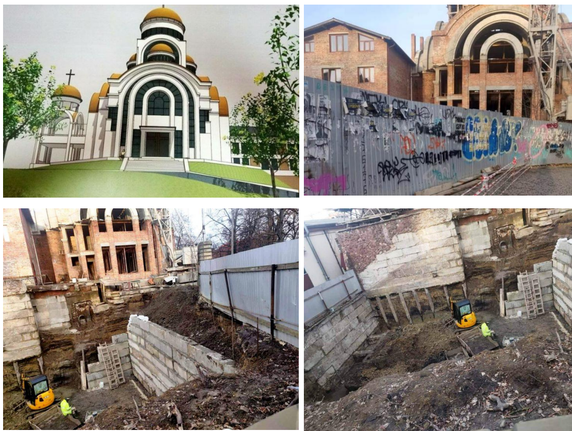
Рис. 3.17. Рис. 1) візуалізація проекту церкви Св. Миколая, 2) будівельні роботи 3-4) земляні роботи
