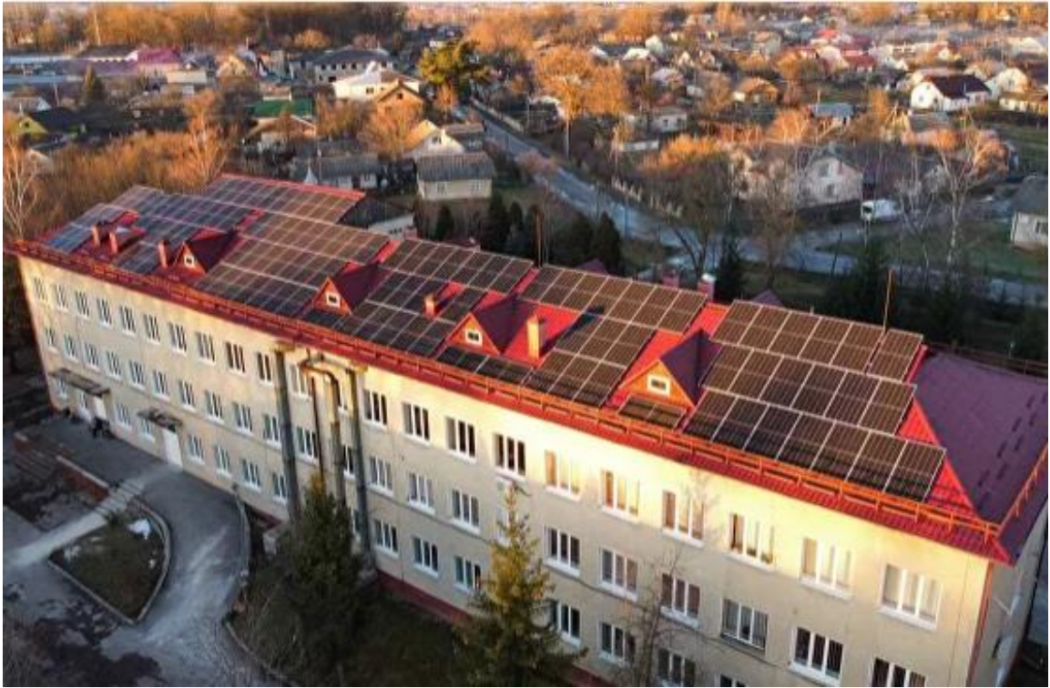
Рисунок 1.8 – СЕС, розміщена на даху Лисецької лікарні
