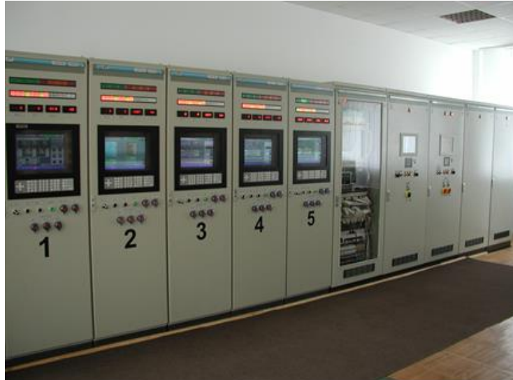
Рисунок 1.5 – Системи автоматичного керування ГПА та КС (на прикладі КЦ-3 Долинської площадки Богородчанського ЛВУМГ ТОВ «Оператор ГТС України. Західний регіон»)
