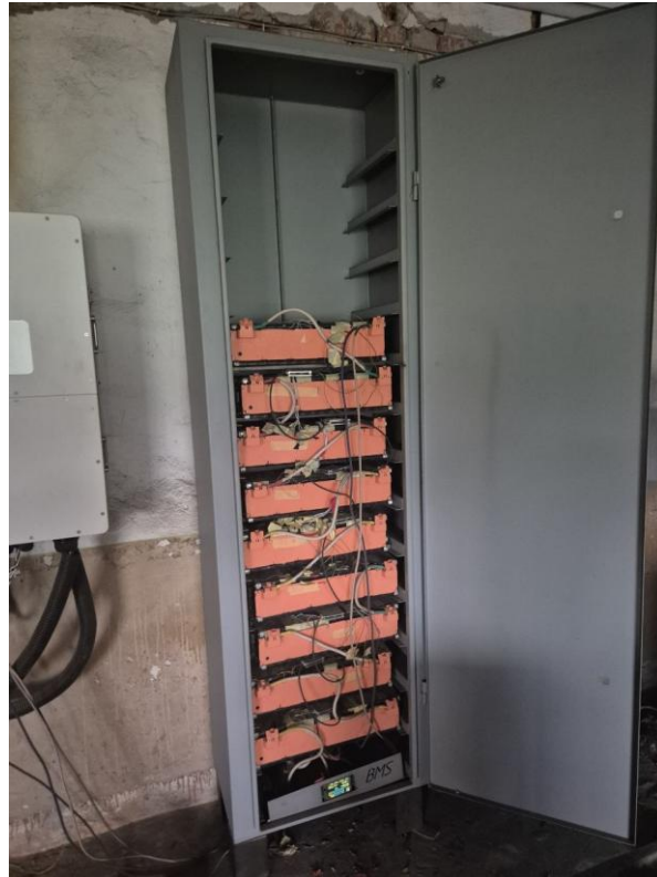
Рисунок 3.1 – Збірка акумуляторів 88s
