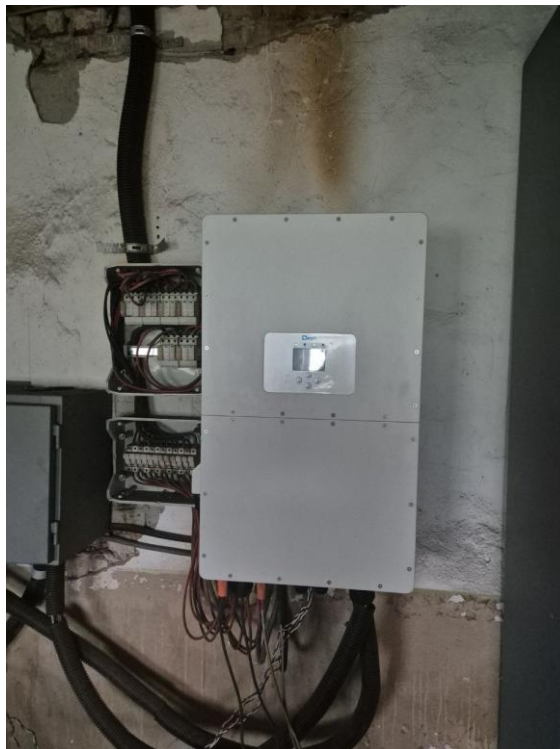
Рисунок 3.3 - гібридний інвертор Deye SUN-30K-SG01HP3-EU-BM3
