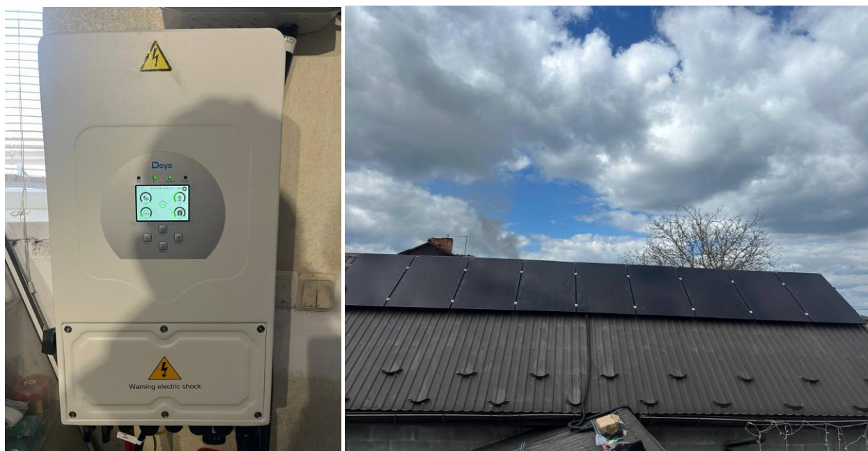
Рисунок 1.1 – Приклад реалізації однофазної гібридної фотоелектричної станції потужністю 8 кВт побутового призначення.
