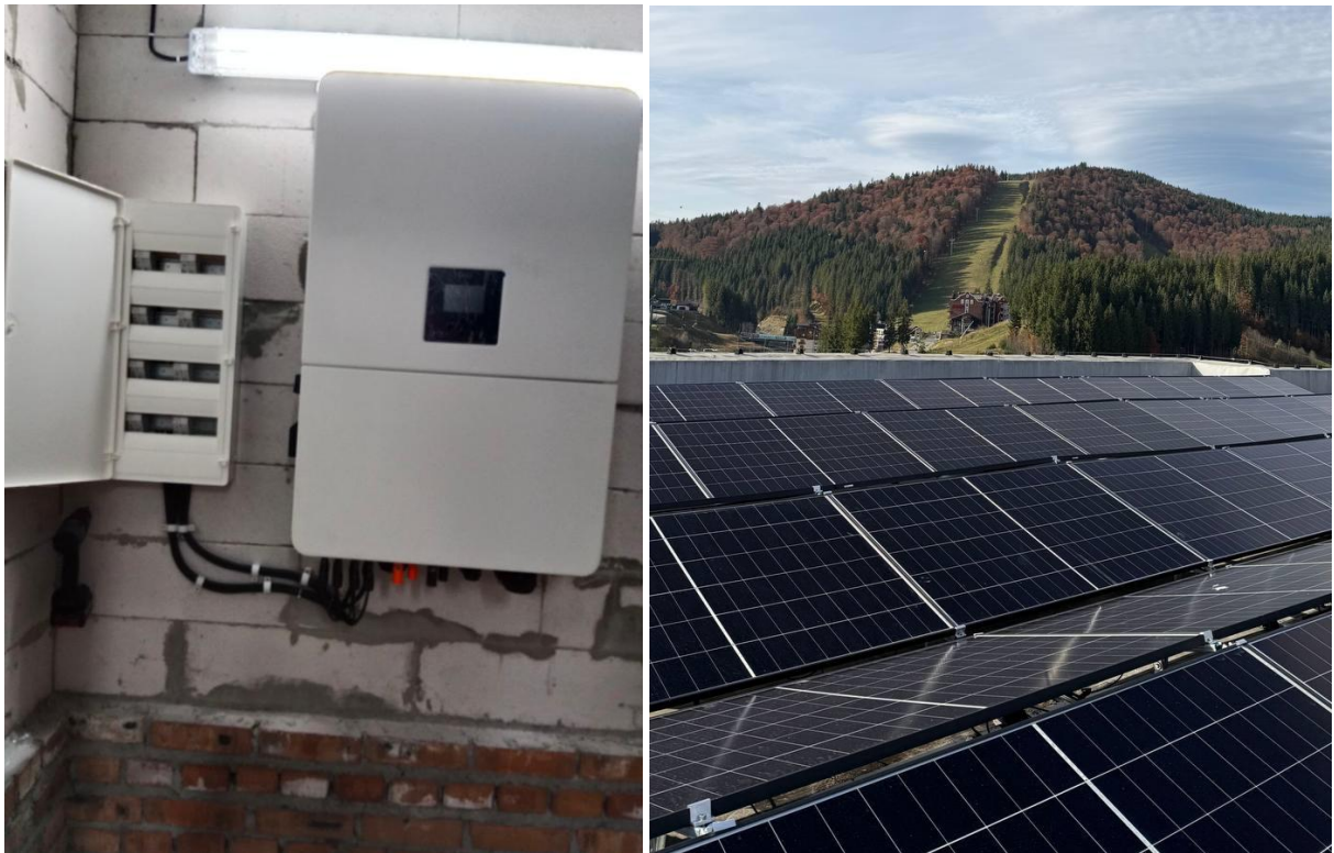
Рисунок 1.2 – Приклад реалізації трифазної гібридної фотоелектричної станції потужністю 50 кВт для комерційного об'єкта.
