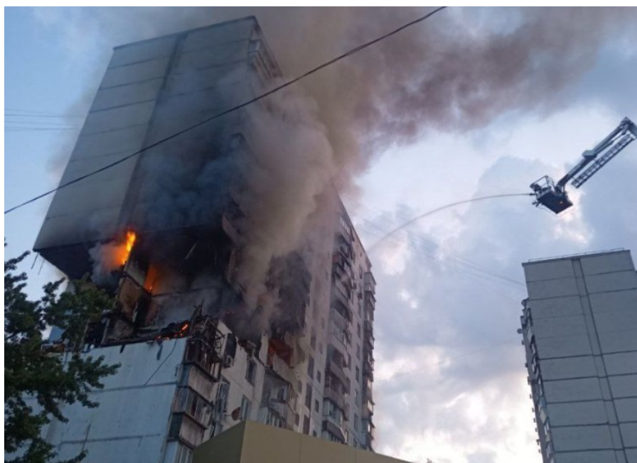
Рисунок 1.2 - Вибух газу та пожежа у 16-поверховому будинку у червні 2023 року в Дніпровському районі міста Києва
