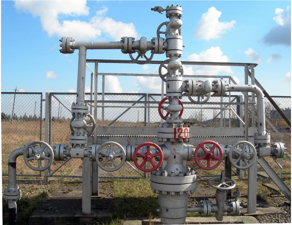
Рисунок 1.12 – Фото вибраної обв'язки устя
