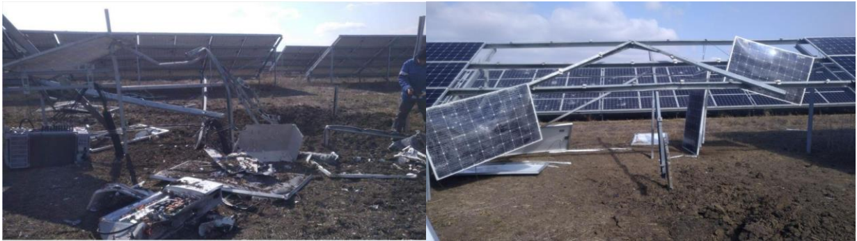
Рисунок 1. 13 - Зруйнована сонячна електростанція (22 МВт) компанії Solar Generation у Миколаївській області [24]
