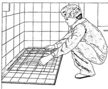
Рис. 3.18. Зняття шаблону.
