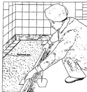
Рис. 3.14. Розрівнювання розчину рейкою по маяках.
