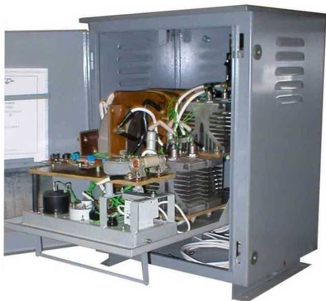
Рисунок 1.9 – Конструкція трансформаторної станції
