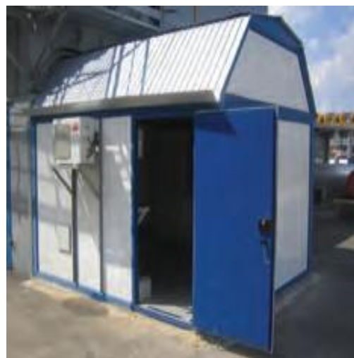
Рисунок 1.9 – Щит автоматики САК ГПА на базі ПЛК GE Rx3i (а) та апаратний блок-бокс САК ГПА «Неман» (б)
