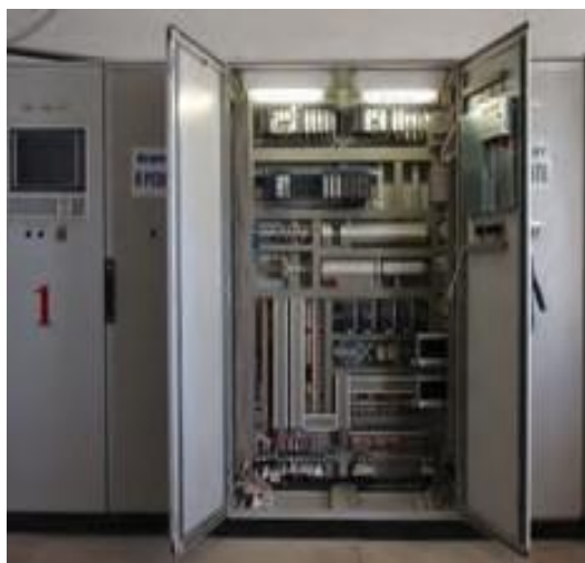
Рисунок 1.9 – Щит автоматики САК ГПА на базі ПЛК GE Rx3i (а) та апаратний блок-бокс САК ГПА «Неман» (б)
