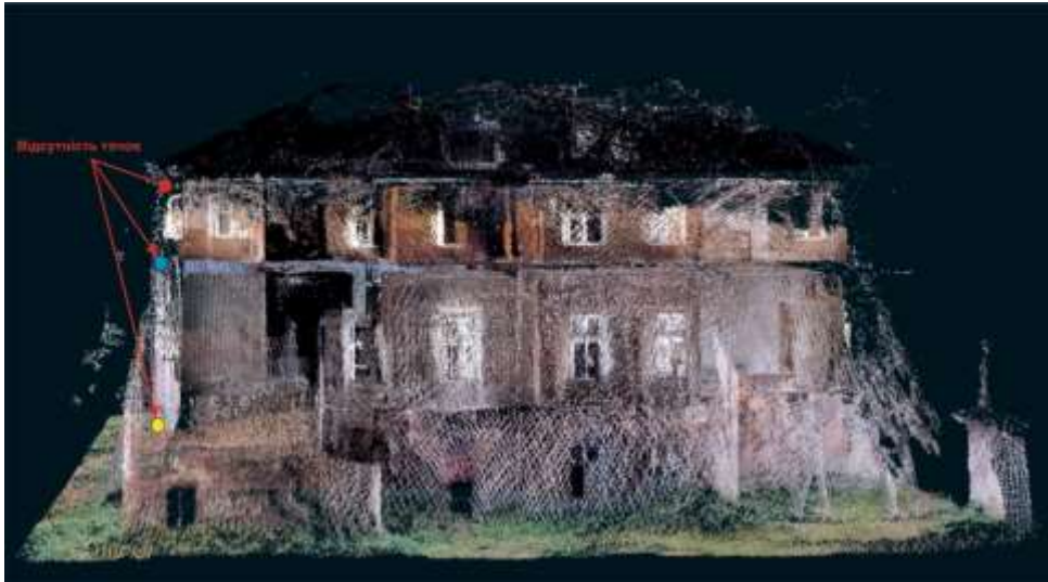
Рисунок 11. Відсутня хмара точок на фасаді
