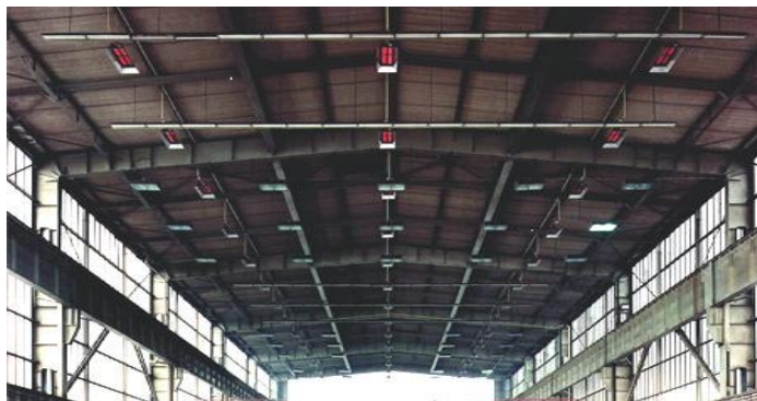
Рис. 3.10 – Розміщення інфрачервоних випромінювачів
