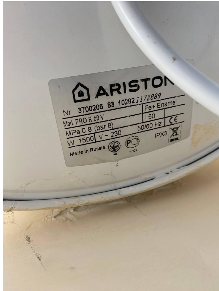
Рисунок 3.10 – Технічні характеристики бойлера
