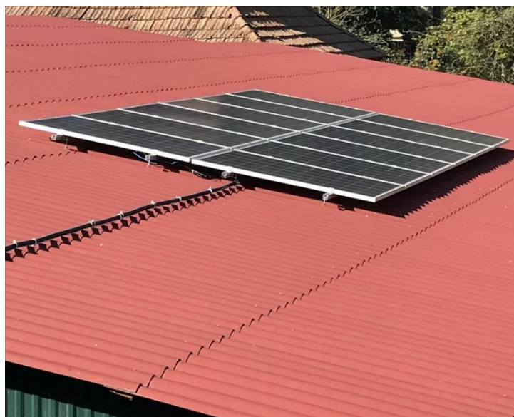
Рисунок 2.4 – 12 фотоелектричних модулів на даху кафедри
