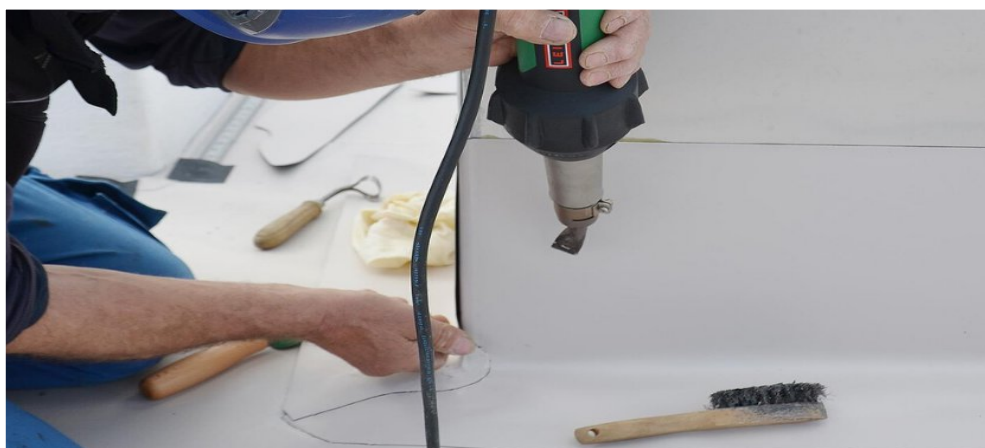
Рисунок 1.4 - Зварювання полімерів гарячим газом
