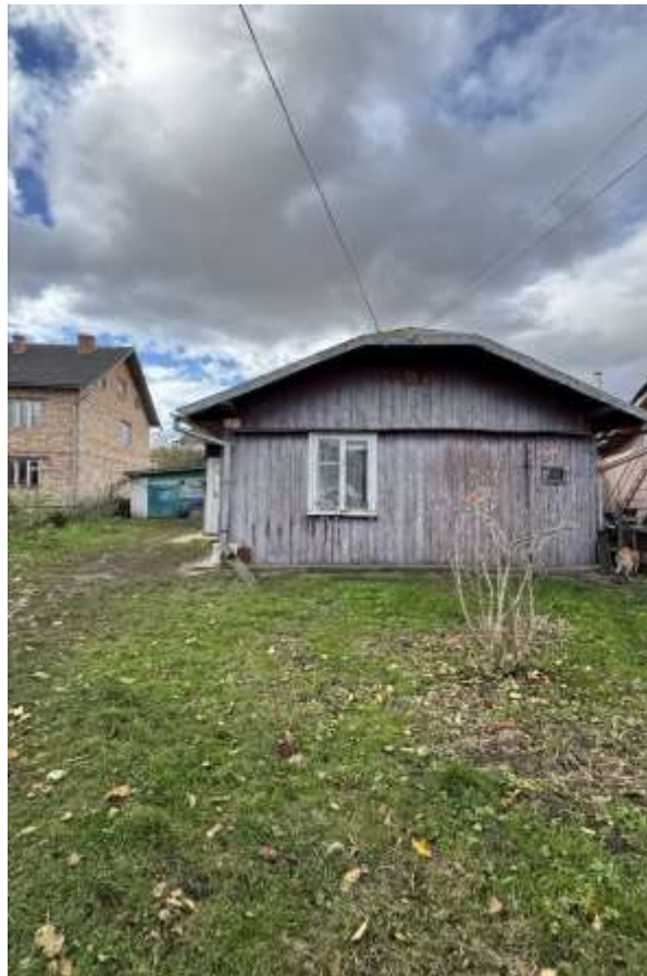
Рисунок 3.5 - Об'єкт під демонтаж з наявною інфраструктурою підключень [30]
