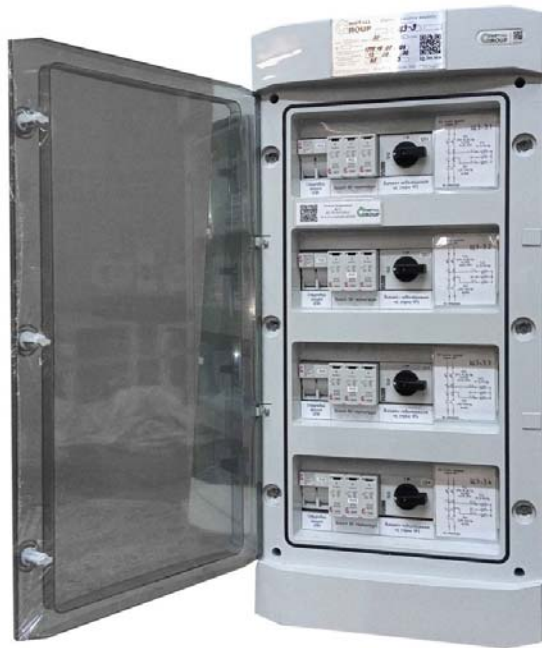
Рисунок 3.13 – Щит захисту контролера 4-стрінговий
