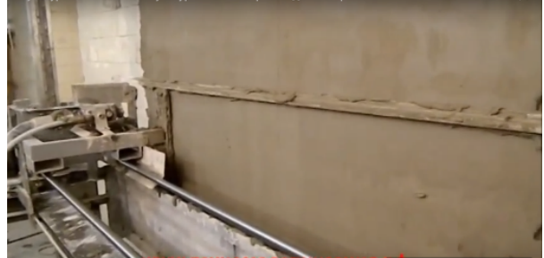
б – розподіл розчину та укладка й розглажування суміщі по вертикальній поверхні
