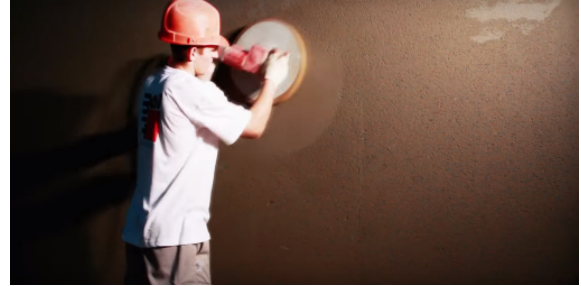
л – перевірка якості поверхні
