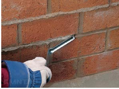
Рисунок 4.10 - Установка порядовки
