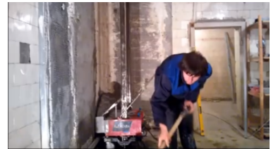
б – подача розчину в бункер
