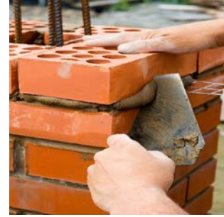
Рисунок 4.13 - Підбір розчину
