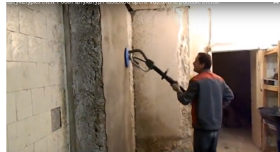
б – розподіл розчину та укладка й розглажування суміщі по вертикальній поверхні
