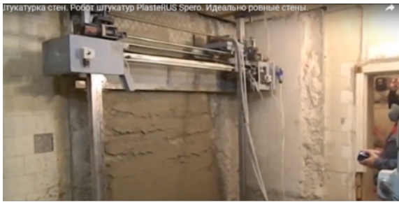
б – розподіл розчину та укладка й розглажування суміщі по вертикальній поверхні
