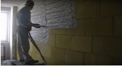
ж – нанесення розчину на поверхню – 20 – 30 см.
