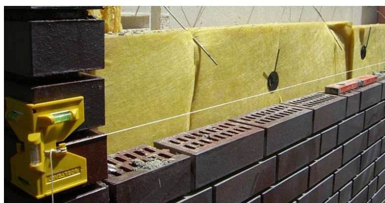
Рисунок 4.9 - Установка плит утеплювача
