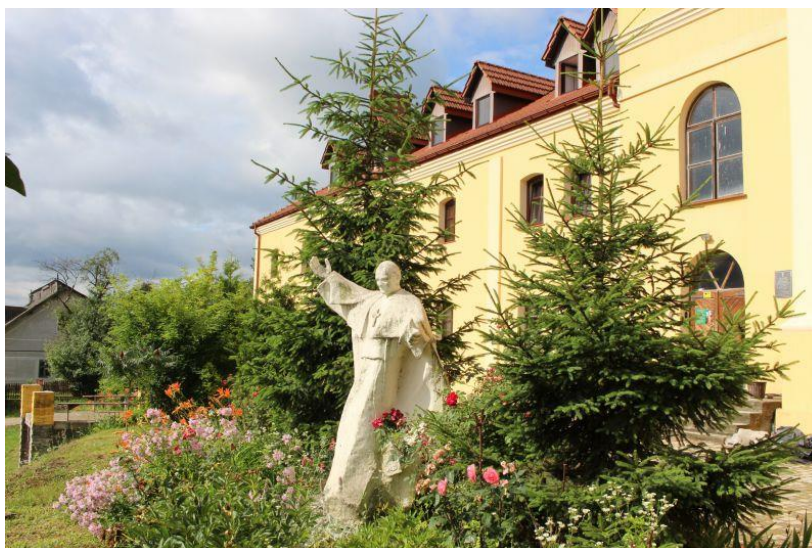
Рисунок 2.5 – Фасад споруди монастирського комплексу Кармелітів
