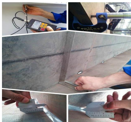
Рисунок 2.14 – Проведення контролю якості при виготовленні коробчатої колони
