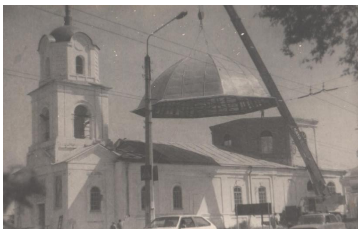
Рисунок 1.36 – Фото 1988 року зі сторони західного фасаду (відсутня дзвіниця і куполи) Рисунок 1.37 – Установка центрального купола
