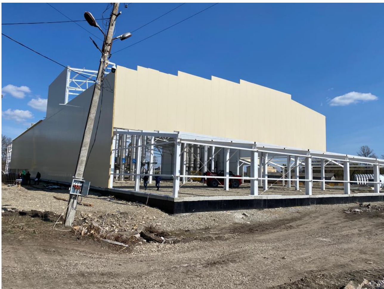
Рис. 1.1 – Будівництво складу концентрату
