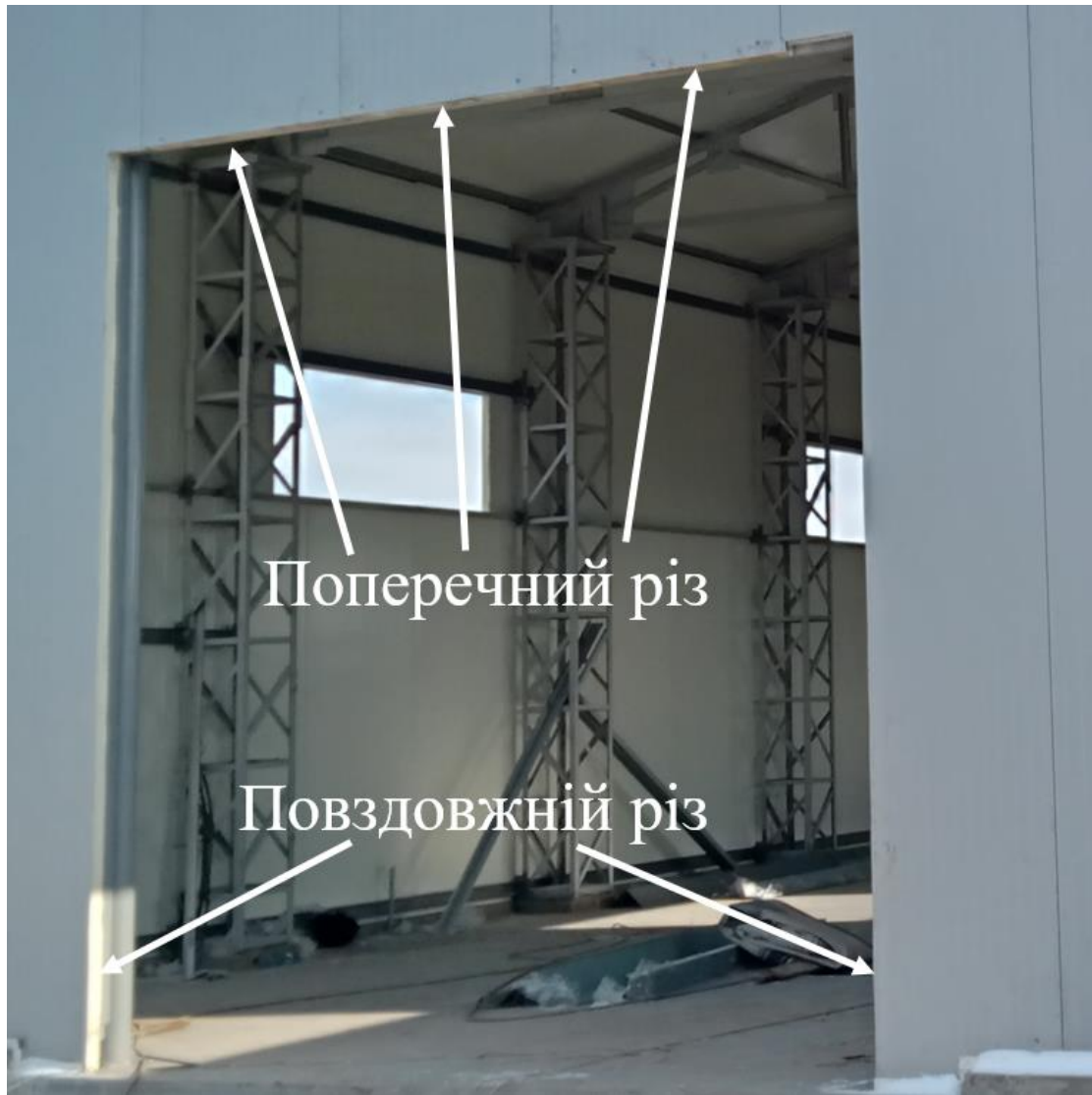
Рис. 3.5 – Приклад повздовжнього різання панелей
