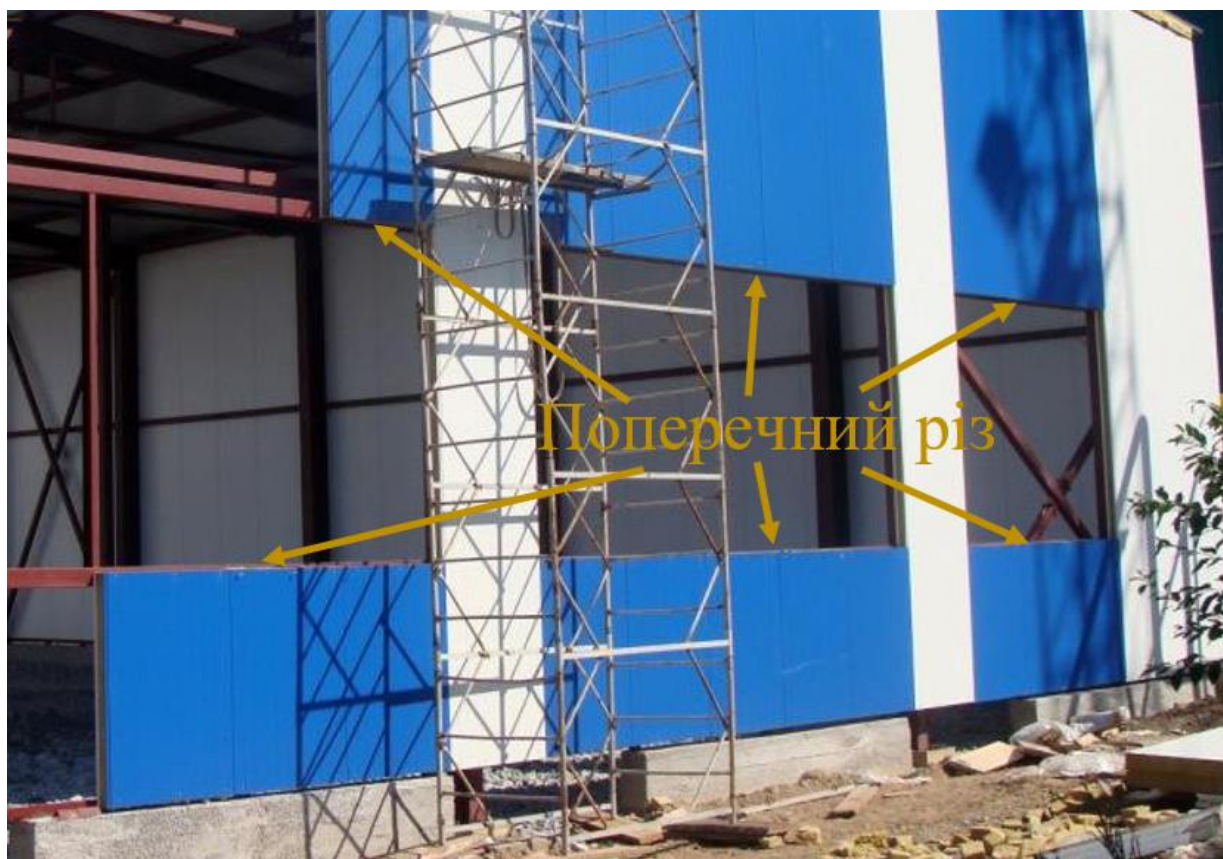
Рис. 3.1 – Приклад поперечного різання панелей
