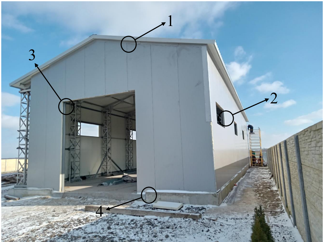
Рис. 1.4 – Приклади необхідності різання сендвіч-панелей
