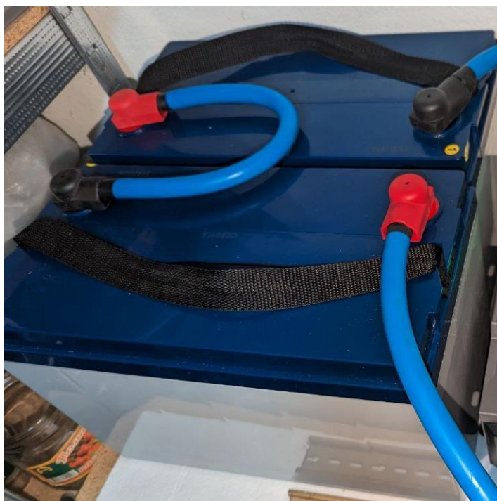
Рисунок 2.4 – Збірка АКБ в 24 В
