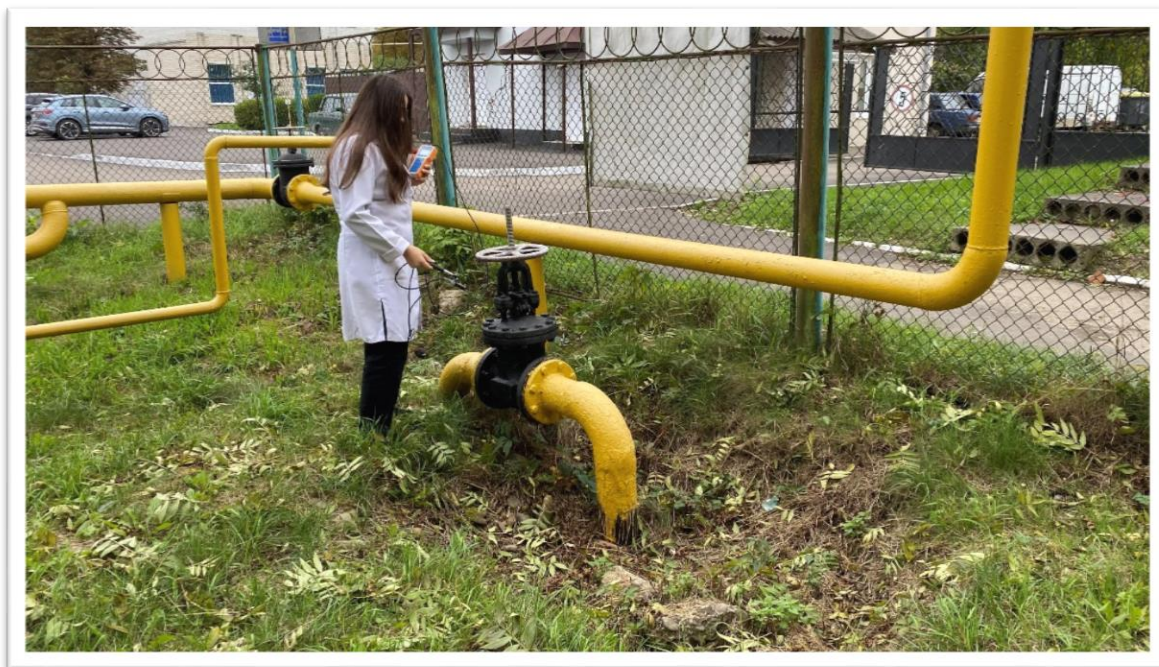
Рис. 4.2 Об'єкт дослідження на території ІФНТУНГ
