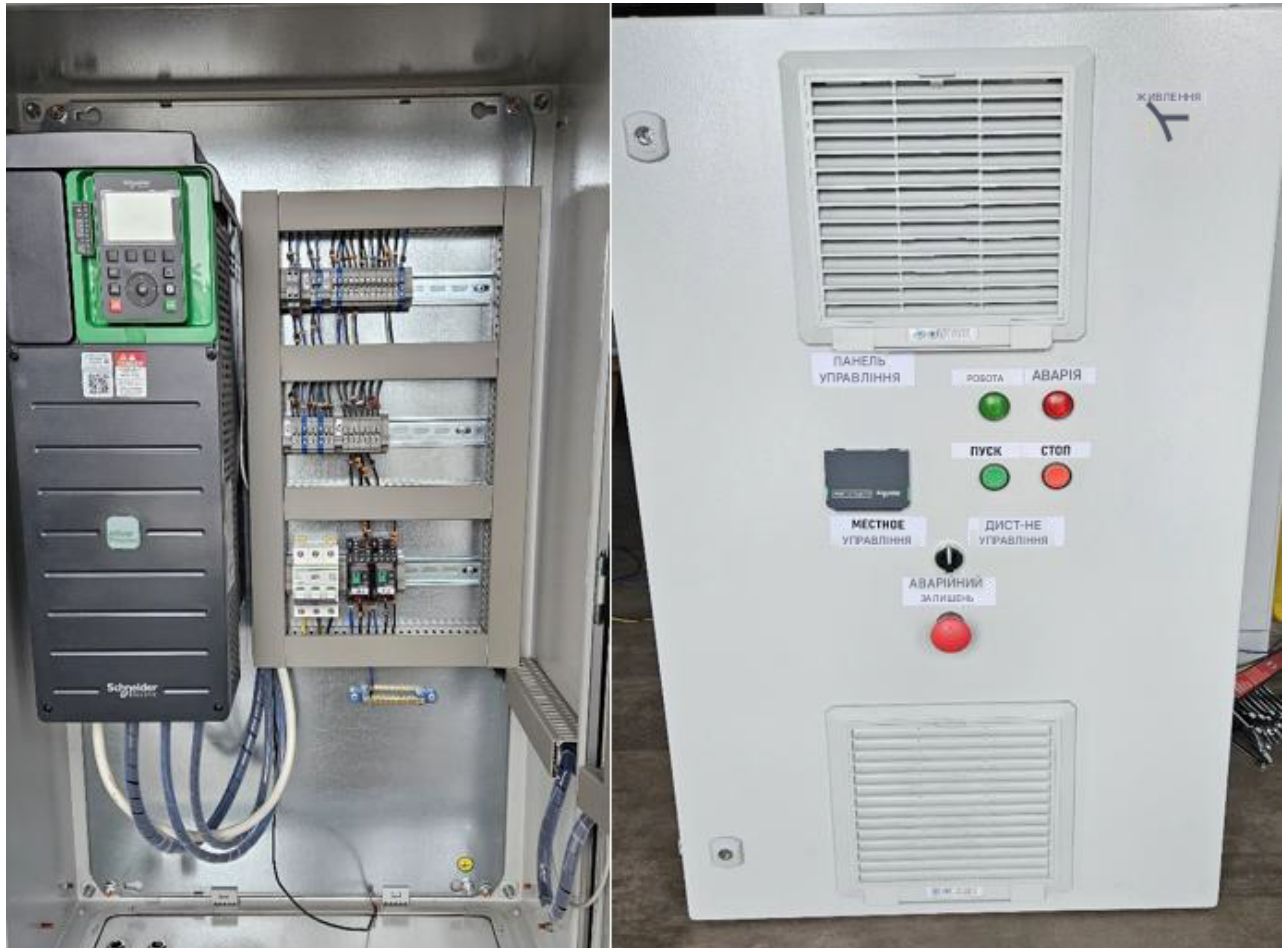
Рисунок 4.11 – Шафа управління у зібраному вигляді
