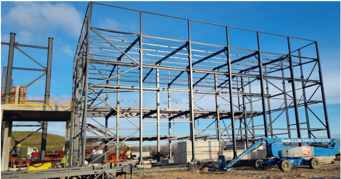
Рисунок 1.1 - Будівництво сміттєспалювального заводу
