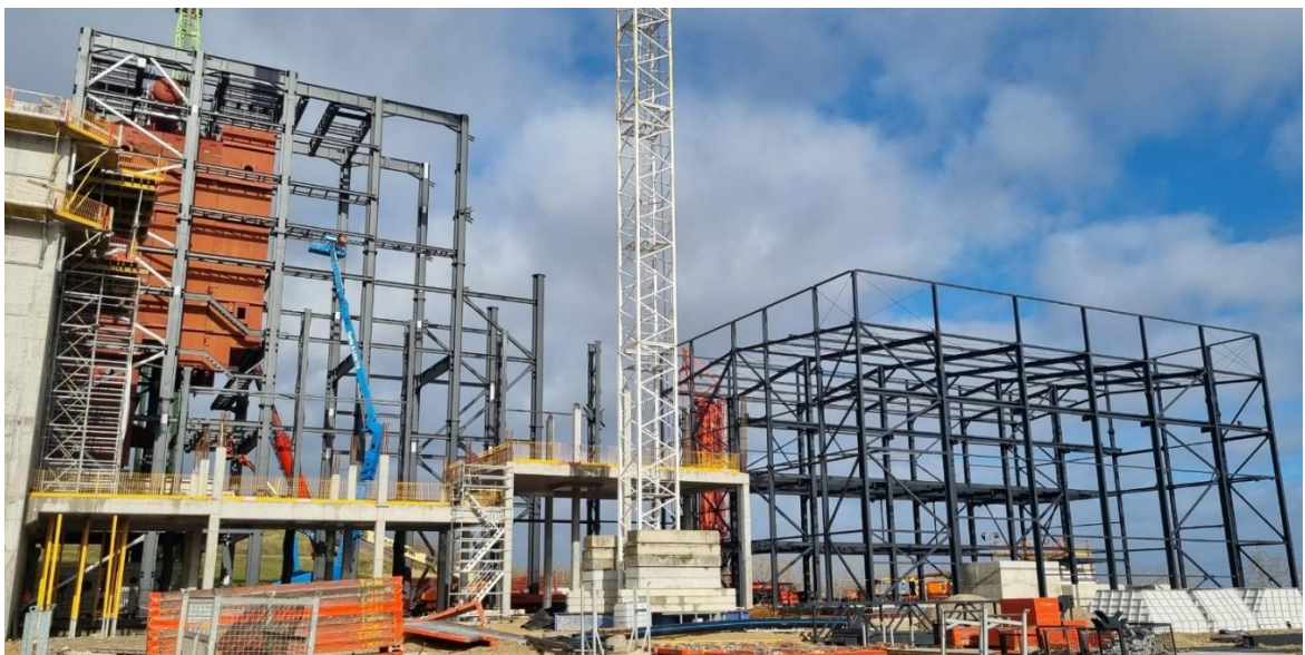
Рисунок 1.2 - Будівництво сміттєспалювального заводу
