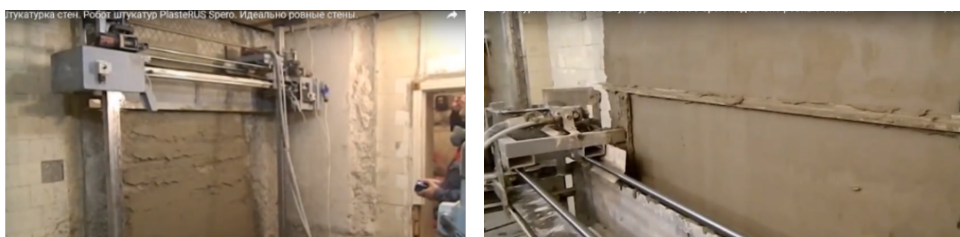
б – розподіл розчину та укладка й розглажування суміші по вертикальній поверхні
