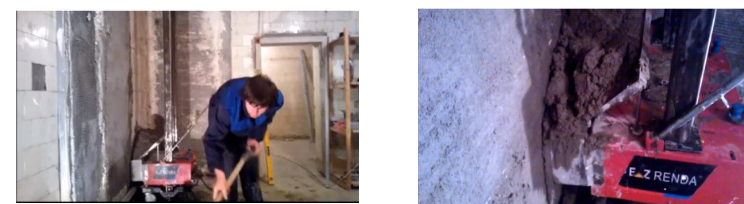
б – подача розчину в бункер
