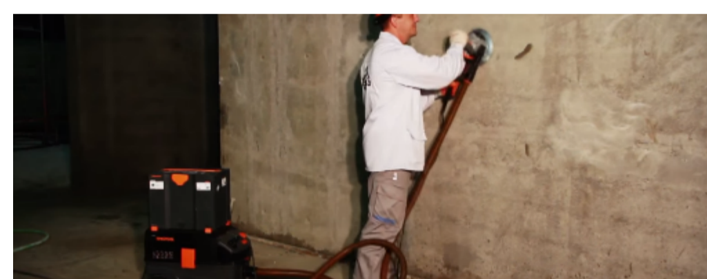
а – очищення поверхні
