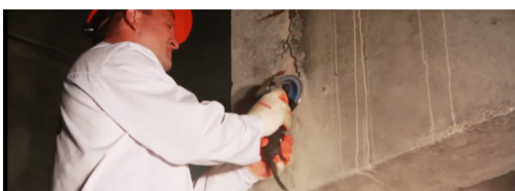
б – видалення наплівів бетону
