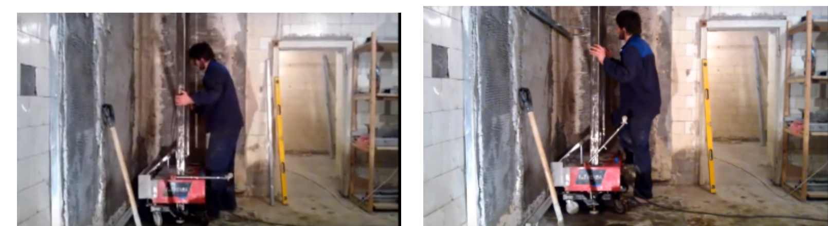
а – монтаж та налаштування обладнання
