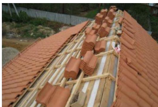
Рисунок 3.7 - Розкладка черепиці на скатах покрівель
