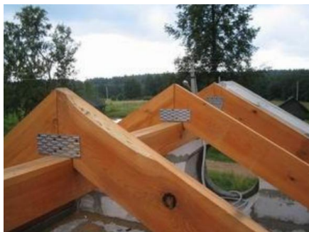
Рисунок 3.2 - З'єднання крокв на гребені
