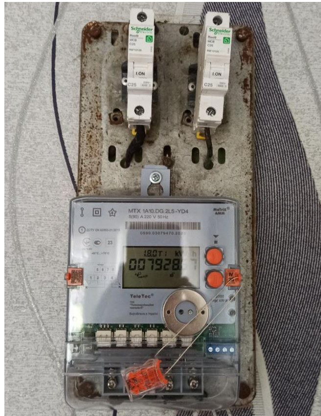
Рисунок 2.1 – Вузол обліку електроенергії житлового будинку
