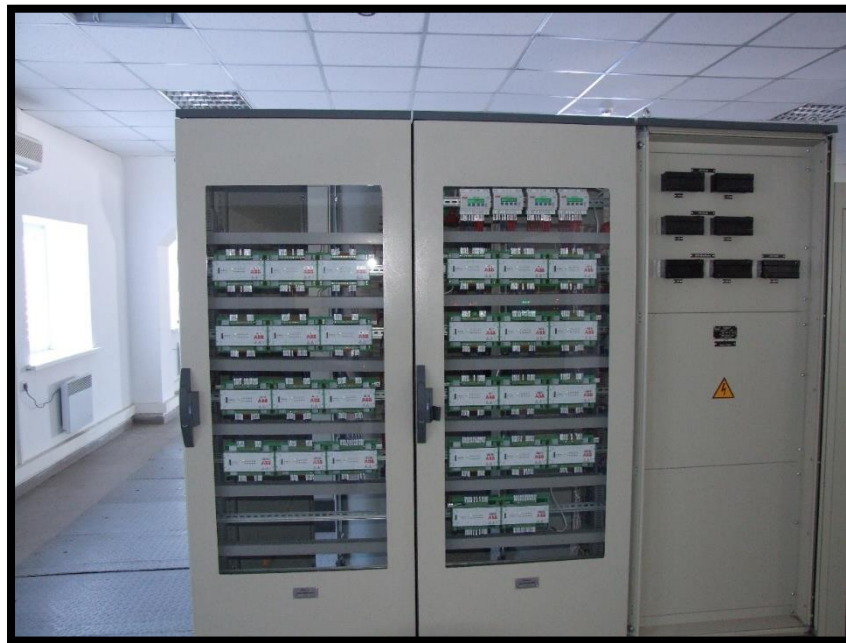
Рисунок 1.2 – Автоматизована система управління підстанцією
