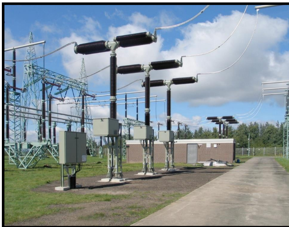
Рисунок 1.3 – Високовольтні вимикачі
