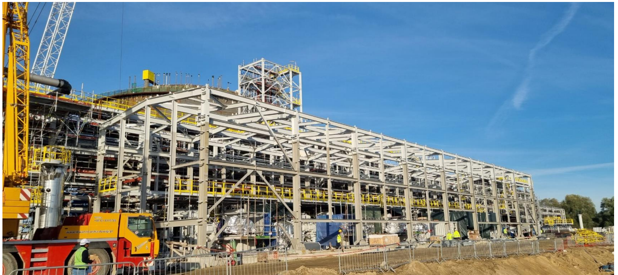
Рисунок 1.1 – Будівництво полеолефінового заводу
