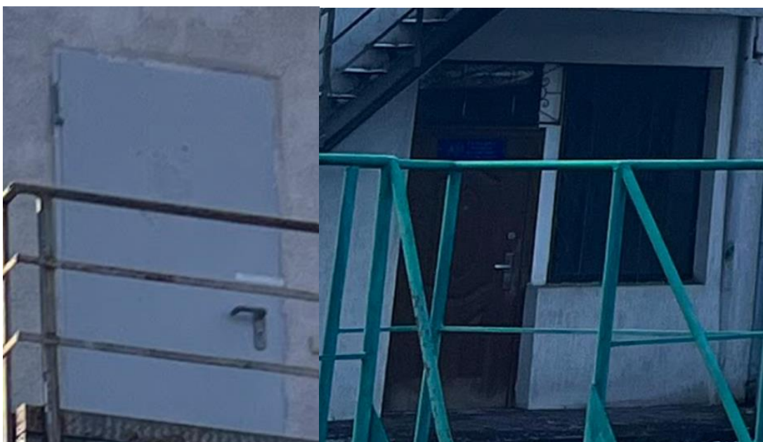
Рисунок 2.22 – Загальний вигляд дверей та воріт в будівлі
