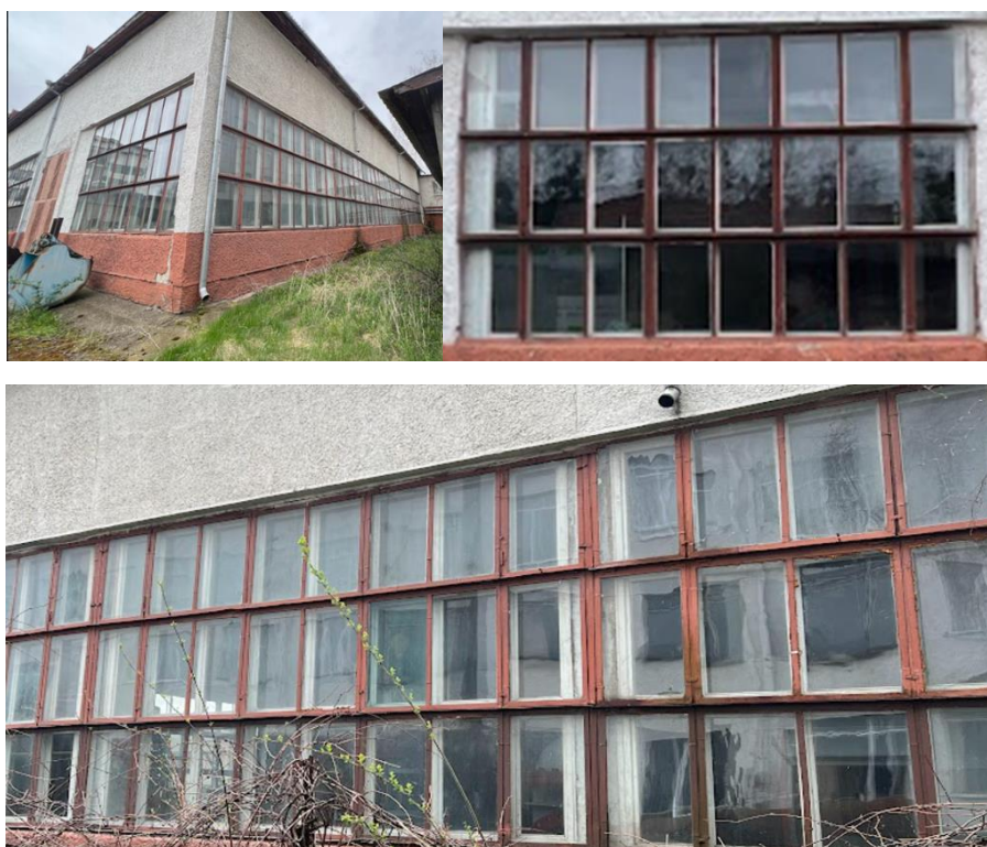
Рисунок 2.19 – Загальний вигляд вікон в дерев'яних рамах
