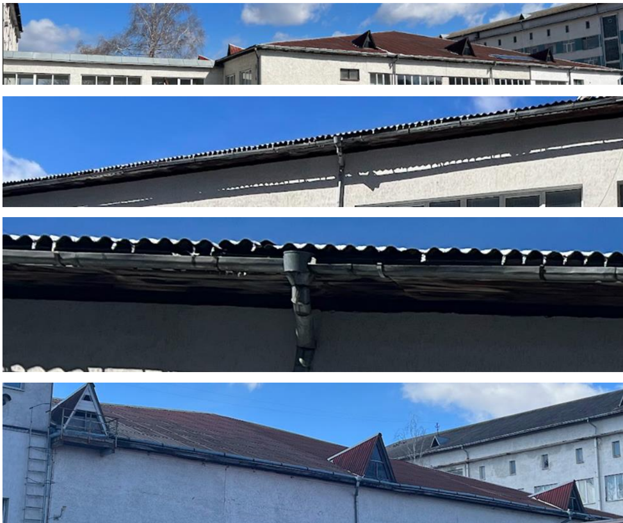
Рисунок 2.23 – Загальний вигляд перекриття будівлі
