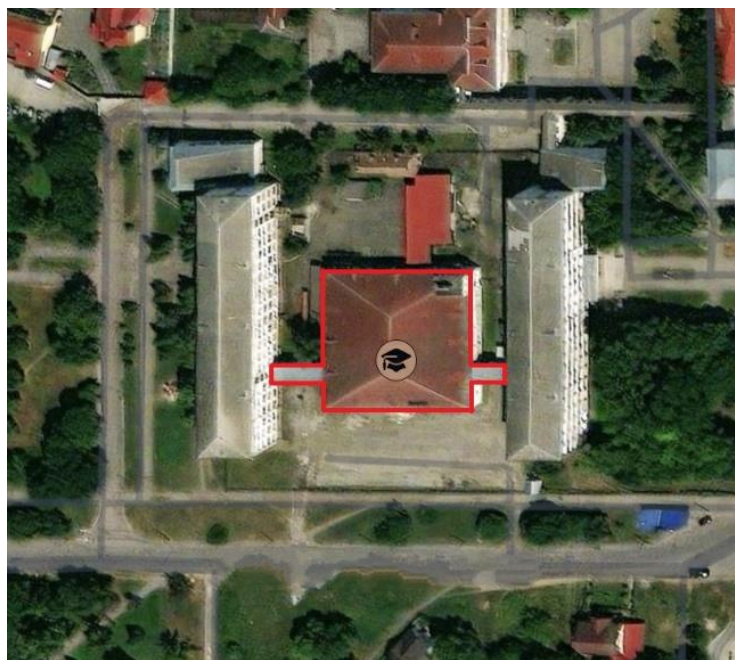
Рисунок 2.1 – Загальний вигляд території корпусу, наведена будівля, яка підлягає енергетичному аудиту
