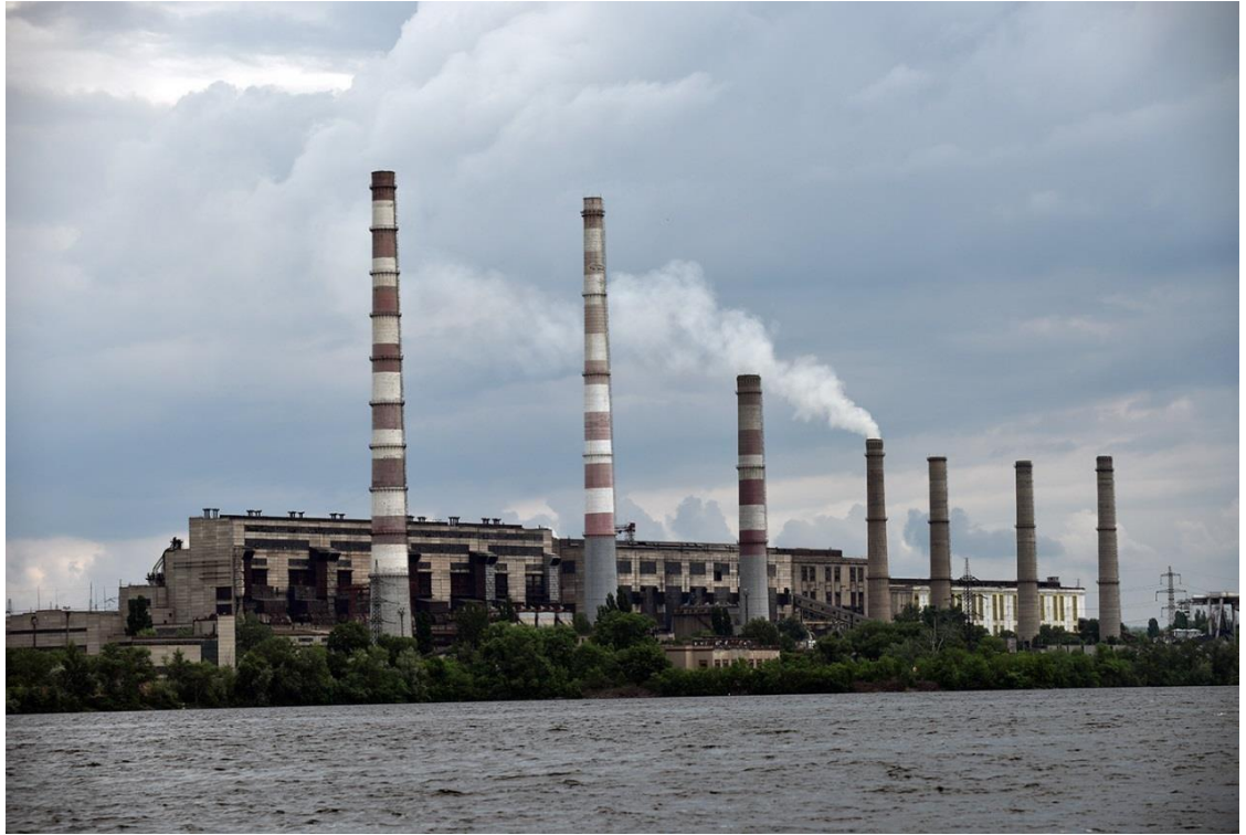
Рисунок 1.3 – Придніпровська теплова електростанція
