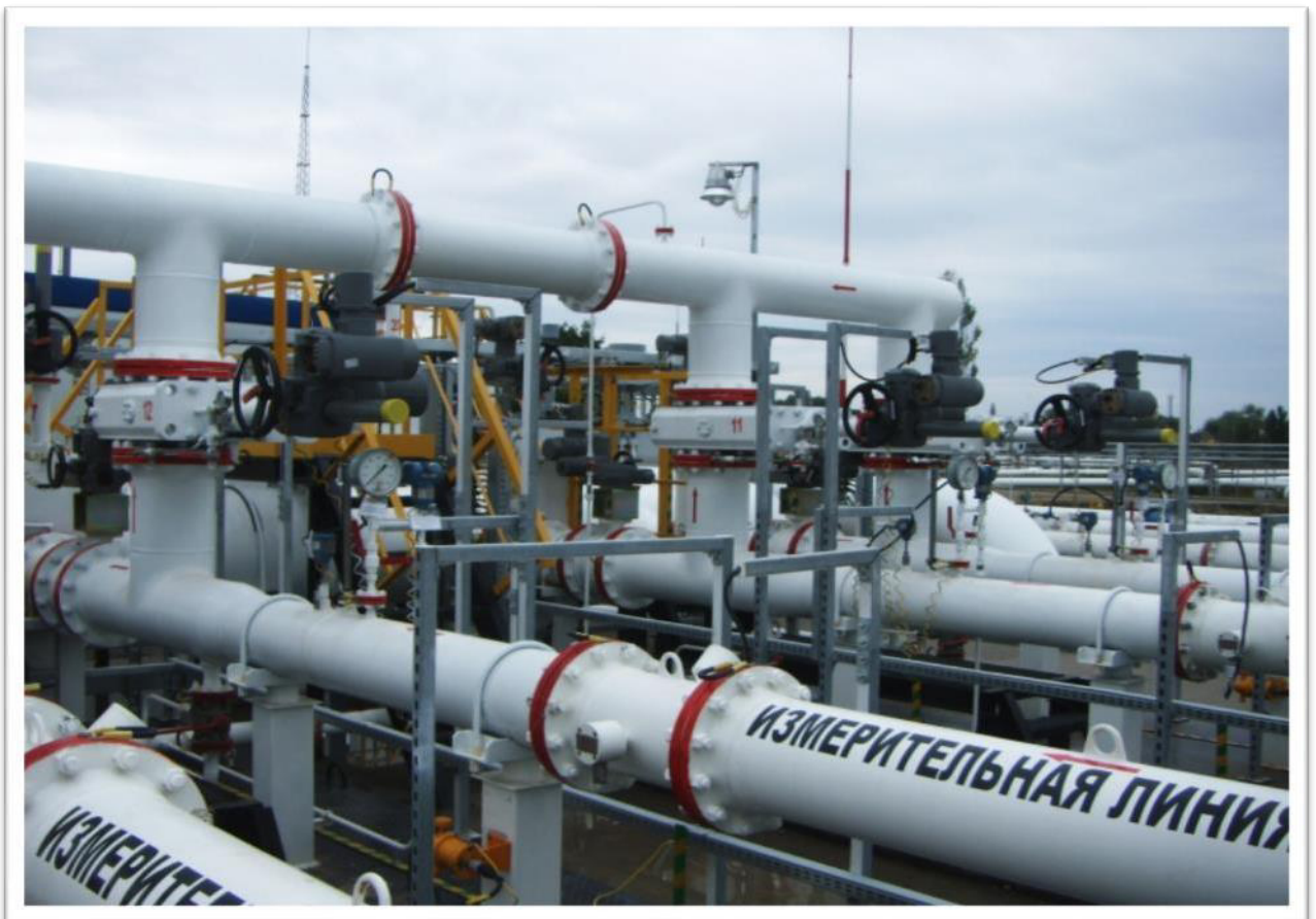
Рисунок 2.1 – Приклад реальної вимірювальної лінії на ТСО
