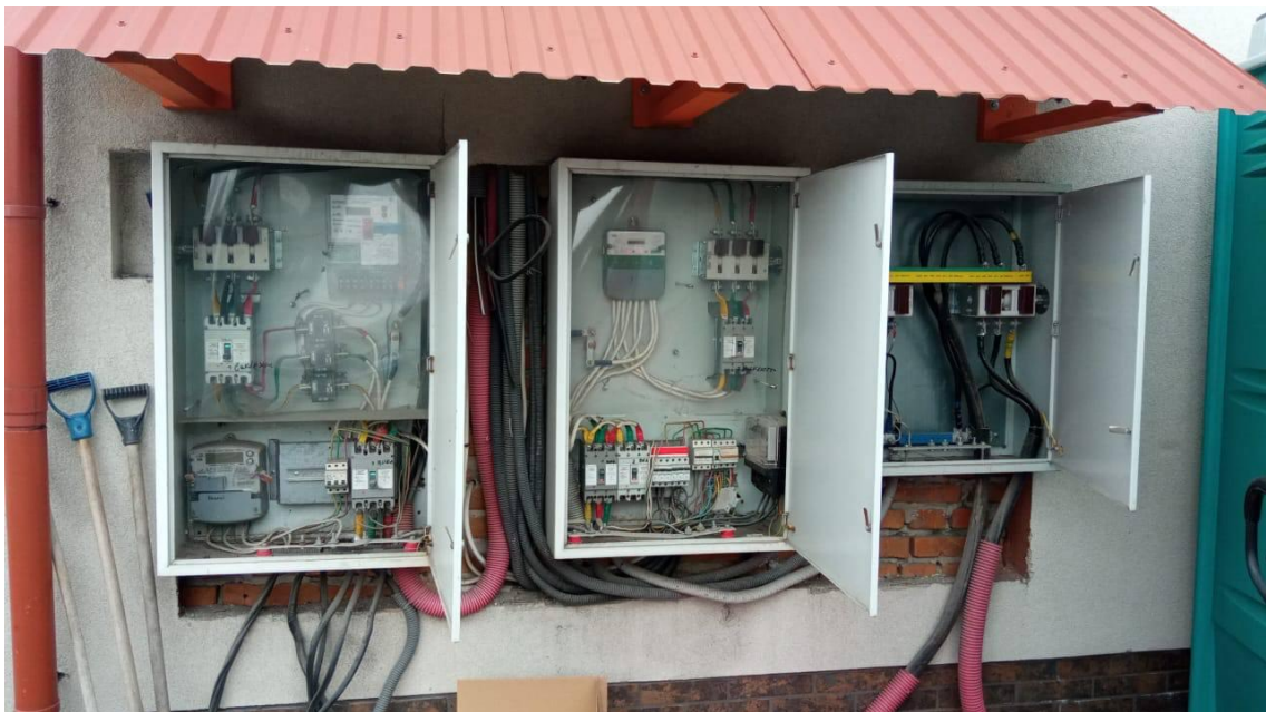
Рисунок 2.11 – Вузол комерційного обліку електричної енергії
