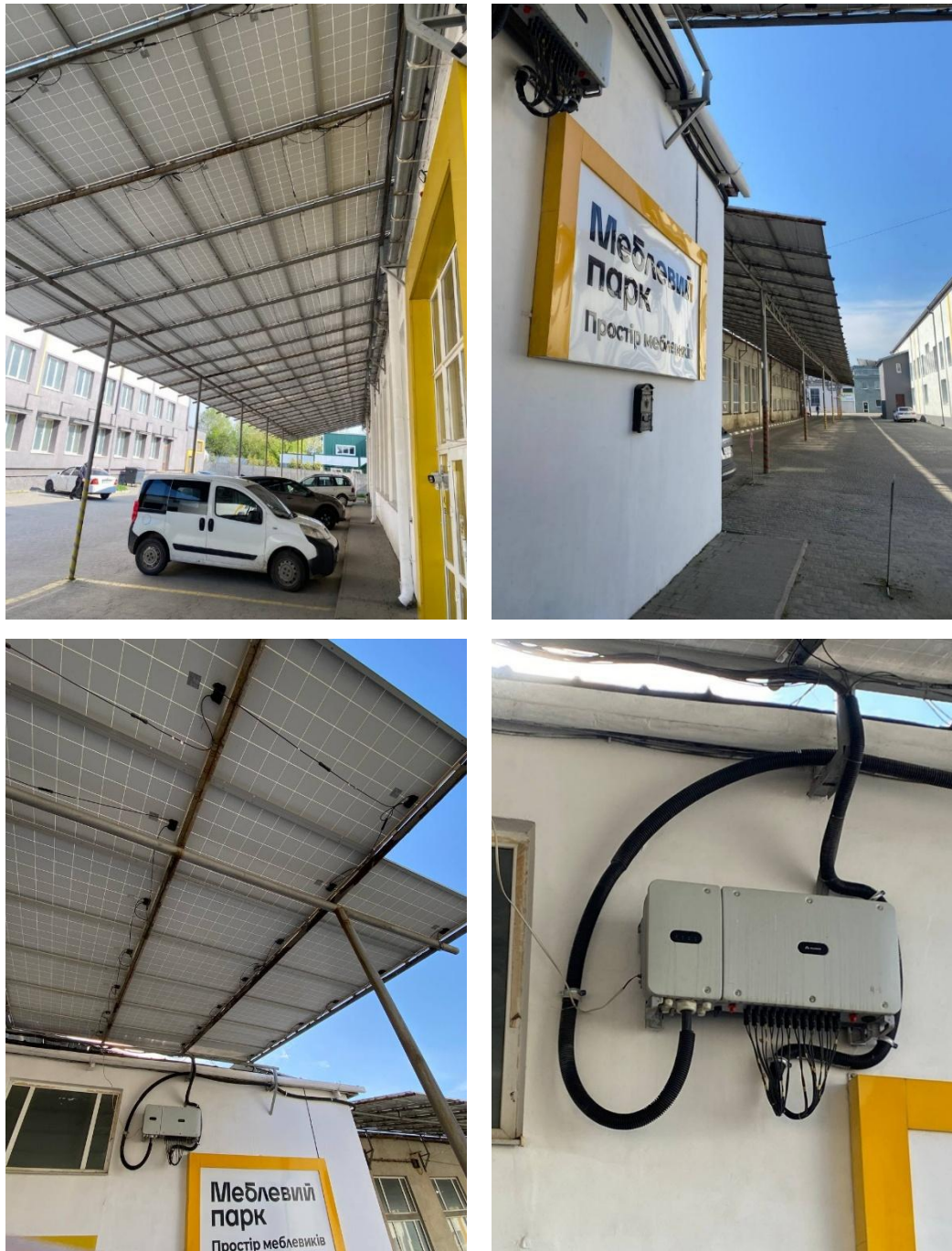
Рисунок 3.3 – Встановлення фотоелектричних модулів на території автомобільної стоянки на підприємстві Меблевий парк
