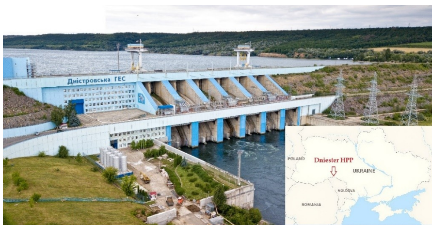
Рисунок 1.1 – Загальний вигляд споруд Дністровської ГЕС-1
