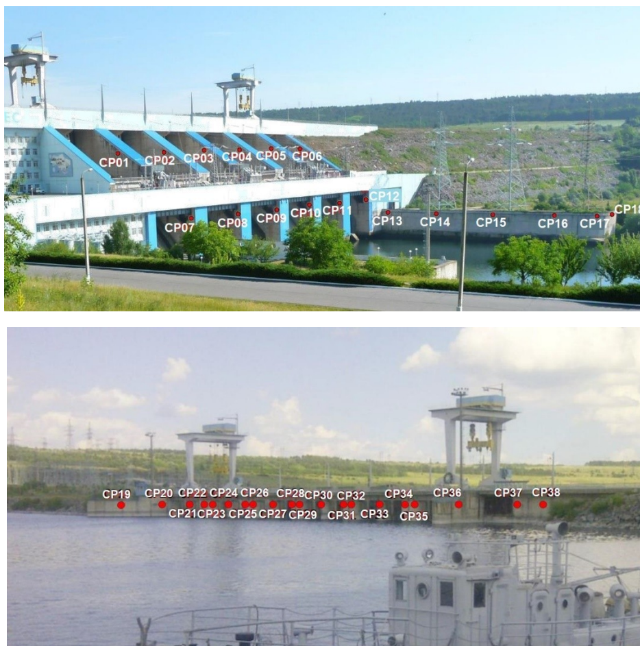
Рисунок 1.4 – а: Просторове розміщення пунктів СР01-СР18 координати яких визначаються лінійно-кутовими методами (вид із пункту DSR1); б: Просторове розміщення пунктів СР19-СР38 координати яких визначаються лінійно-кутовими методами (вид із пункту DSR2)
