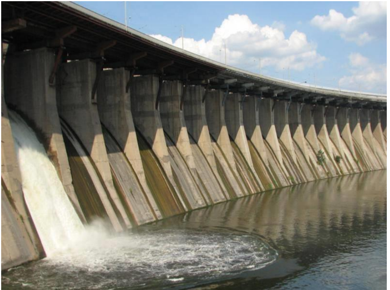
Рисунок 1.2 – Фото гідротехнічної споруди у м.Запоріжжя
