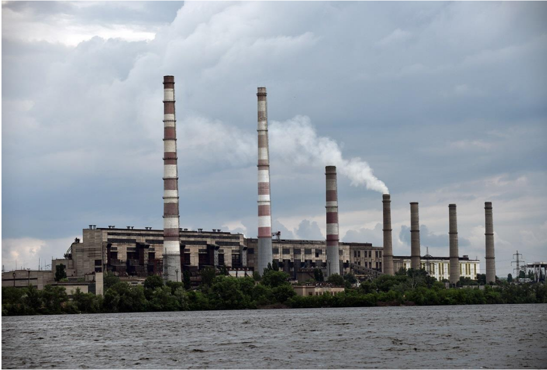
Рисунок 1.3 – Фото Придніпровської теплової електростанції
