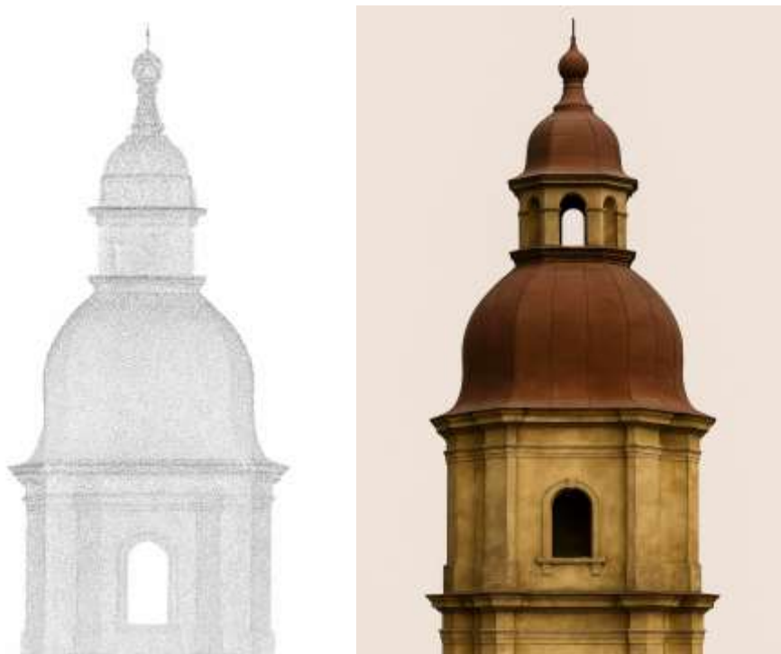
Рисунок 9. Порівняння даних лазерного сканера верхньої частини дзвіниці та відповідної ортофотознімки поверхні, розробленої на основі фотограмметричної 3D-моделі.
