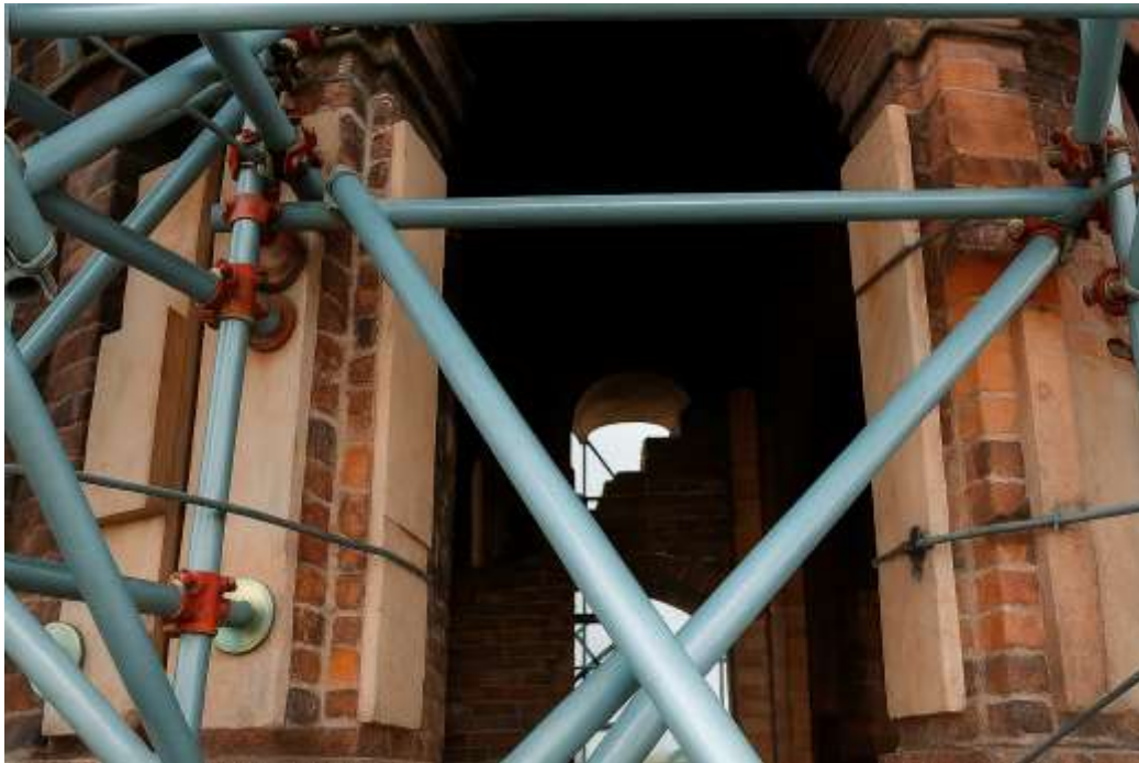
Рисунок 5. Умови проведення сканування верхньої частини дзвіниці: перешкоди у вигляді металевих риштувань та дерев'яної підпірної конструкції.
