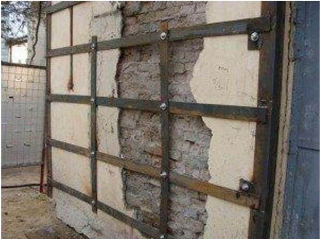
Рисунок 3.5 – Підсилення стіни методом металевої обойми
